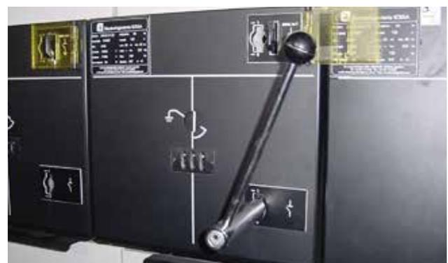
2. Introducir la manija en el orificio del seccionador de puesta a tierra y llevar éste a la posición "cerrado". Una vez realizada esta maniobra, se libera el enclavamiento que bloquea la apertura de la puerta frontal, quedando de esta forma accesible el recinto de cables.
